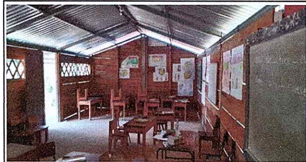
SUSTITUCIÓN DE MADERA POR BLOK
