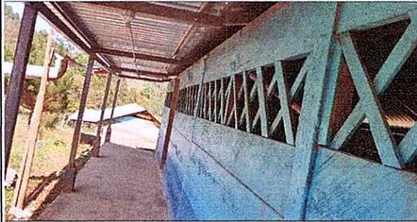
SUSTITUCIÓN DE LOSA DE CONCRETO Y DE PARALES DE MADERA POR CONCRETO Y SUSUTITUCIÓN DE MADERA POR BLOK
