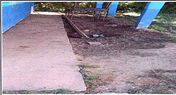
SUSTITUCIÓN DE PLANCHA DE CONCRETO
