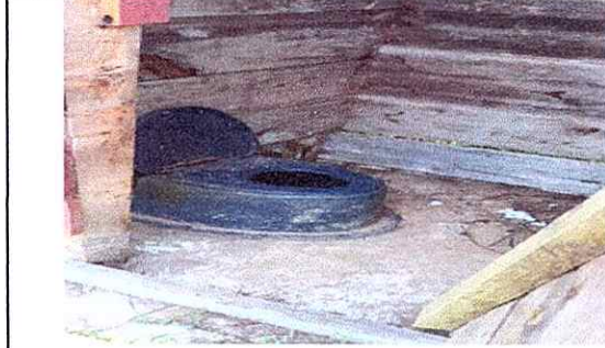
SUSTITUCIÓN DE LETRINA Y DE PUERTAS DE SANITARIO
